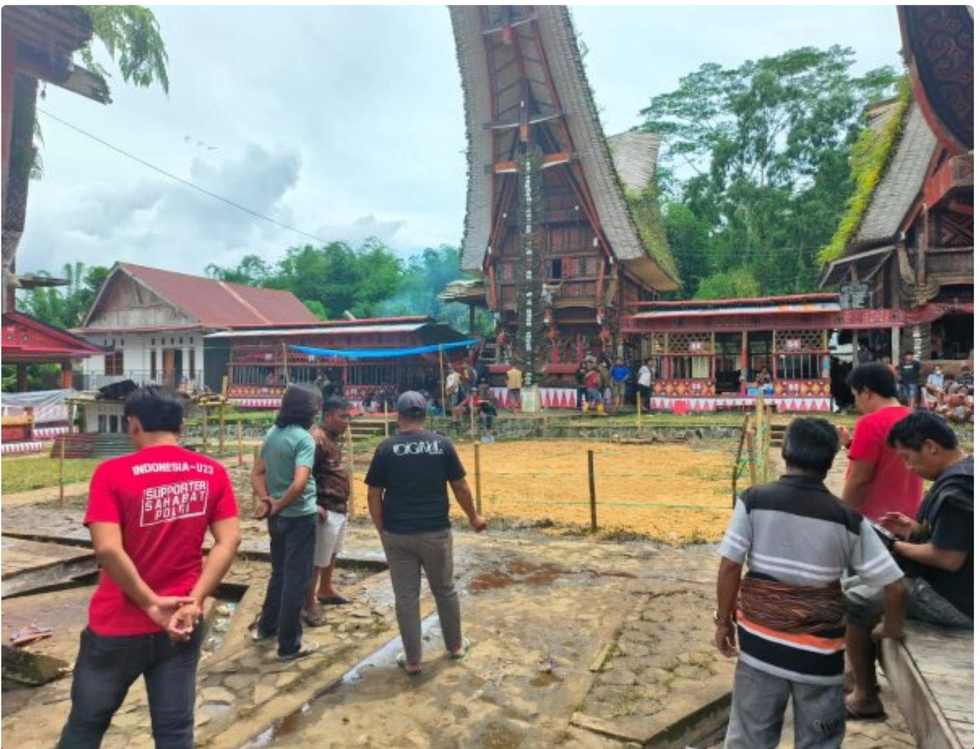
Pembongkaran Arena Judi Sabung Ayam di Sangalla
